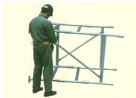
②スタッキングフレームを対面する2構面ずつ差し込み、ダイアゴナルストラットを取付けます。タワーの必要高さまでこの作業を繰り返します。
