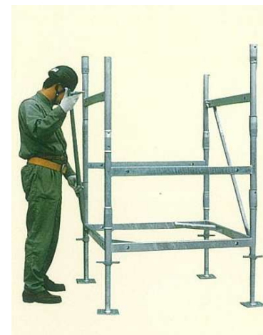
④ダイアゴナルストラットを取付けます。
