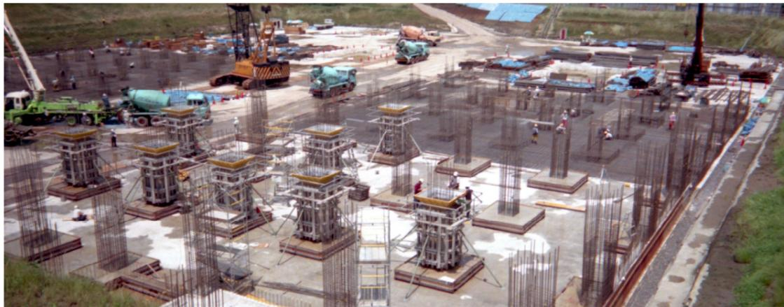
L型の型枠の組合せで解体・盛替が容易に行えます！
