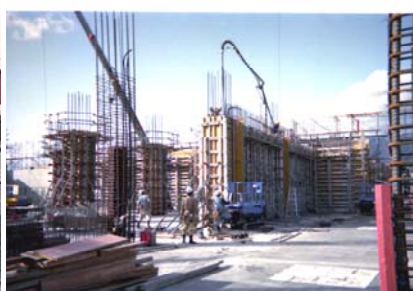
コンクリート打設
