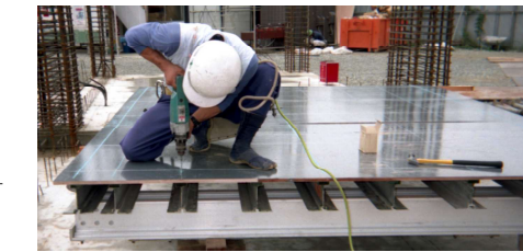
⑧ 建込は定規アングルを躯体寸法よりアングルの肉厚分だけ内側に、コンクリート釘で固定する。
