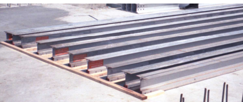
② 墨出した大矩に合わせて栈木を釘止めし、それに垂直に短い栈木をアルマビーム(横バタ)の間隔に合わせて釘止める。
