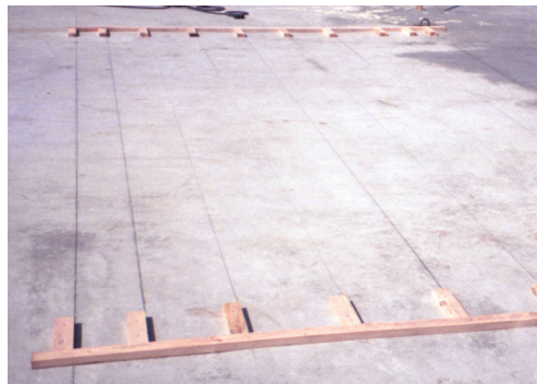
② 墨出した大矩に合わせて栈木を釘止めし、それに垂直に短い栈木をアルマビーム(横バタ)の間隔に合わせて釘止める。
