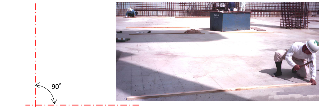
① 水平な地組場所に大矩を墨出しする
