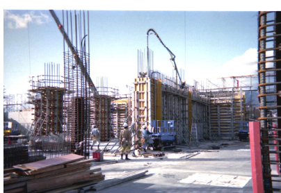
コンクリート打設
