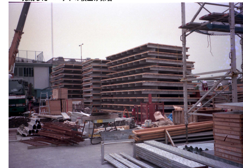
完成したユニットの積上げ保管
