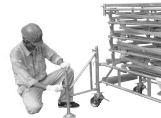
キャスターのブレーキをロックし、アウトリガーをセットする
