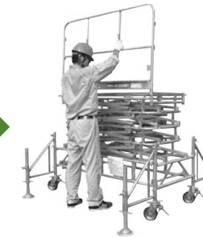
作業床の手すり等をセットする
