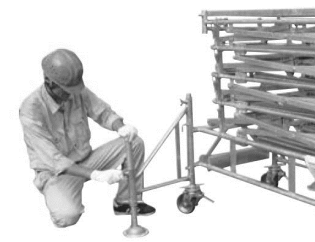
キャスターのブレーキをロックし、アウトリガーをセットする
