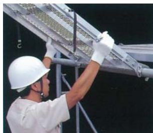
①下段足場板のフックを架けます。
