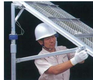
③中間支柱の方杖を下段足場板に仮固定します。
