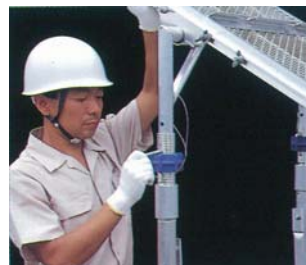
②中間支柱の高さを荒調整します。
