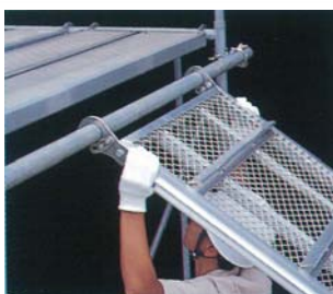
④上段足場板のフックを架けます。
