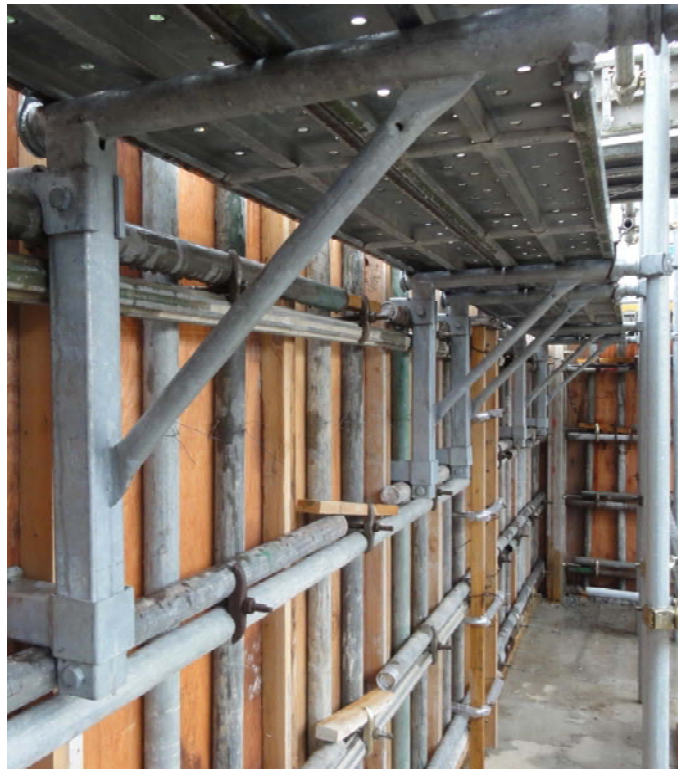
先端の支持パイプの変位防止は確実にお願いします
