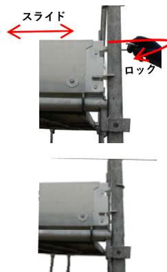
フックで支柱を挟み込み、外れ止めをロックする
